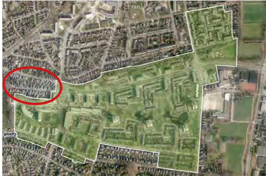
Wederopbouwwijk Kerschoten en ligging Hertenaan en Reeënlaan
