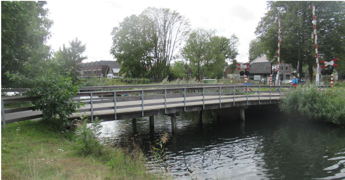
Figuur 4 Bestaande houten fietsbrug
