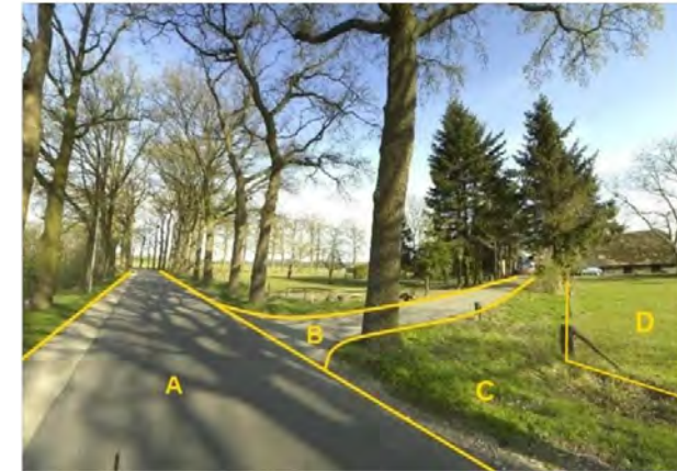
A = wegdeel : rijbaan, lokale weg : gesloten verharding B = wegdeel : inrit C = ondersteunend wegdeel : berm : groenvoorziening
