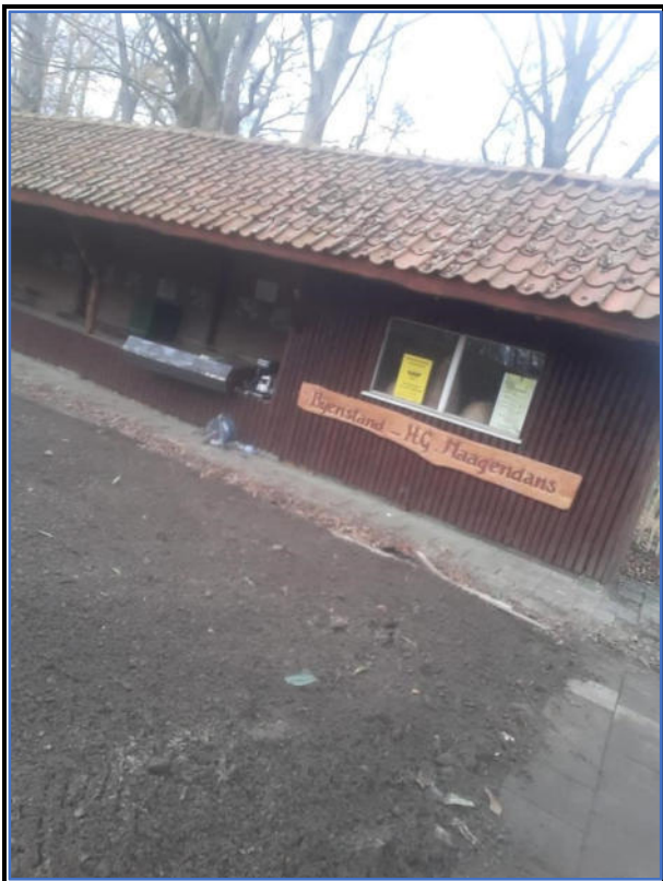
Foto 4: afgeronde werkzaamheden zuidzijde bijenkasten
