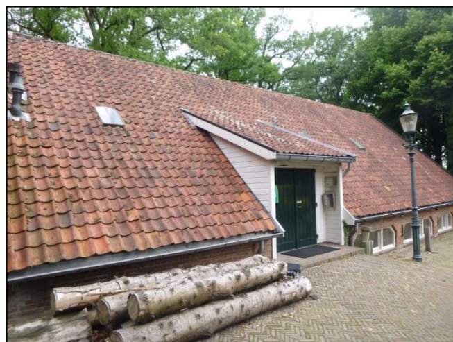
Foto 24: Buitengevel: Boeideel (Niet asbestverdacht)
