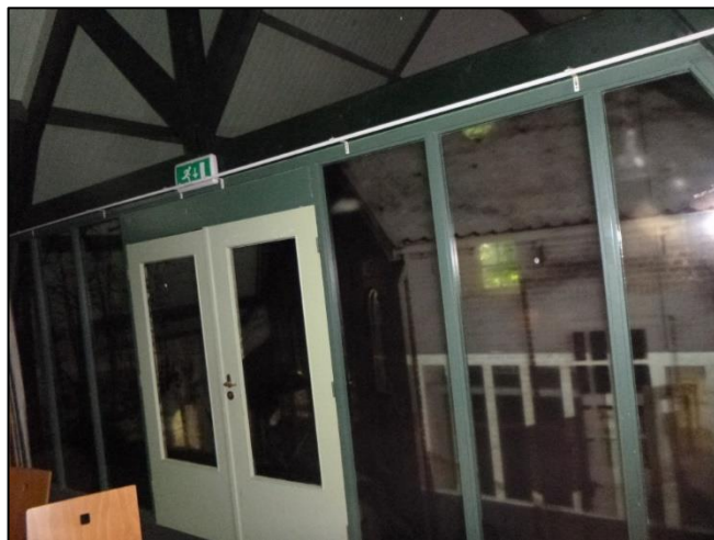
Foto 40: Vide: Beglazingskit (Niet asbestverdacht)
