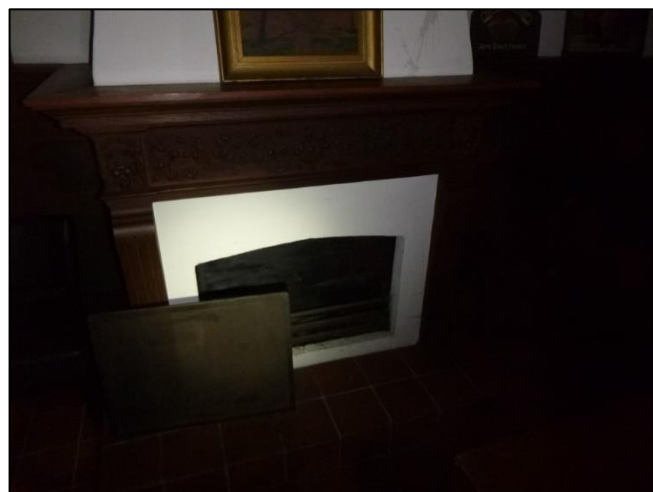
Foto 46: Zaal: Schoorsteen (Ontoegankelijk)
