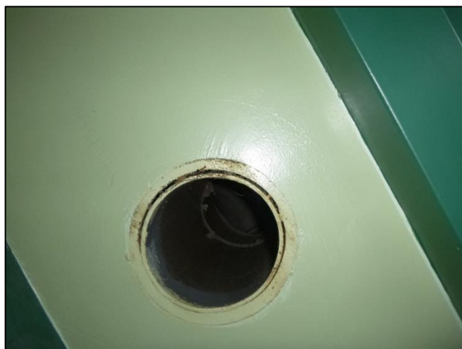
Foto 34: Toilet: Ventilatiekanaal (Niet asbestverdacht)
