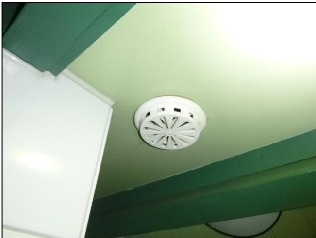
Foto 37: Toilet: Ventilatiekanaal (Niet asbestverdacht)
