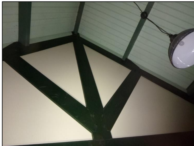
Foto 26: Korenschuur: Dakbeschot (Niet asbestverdacht)
