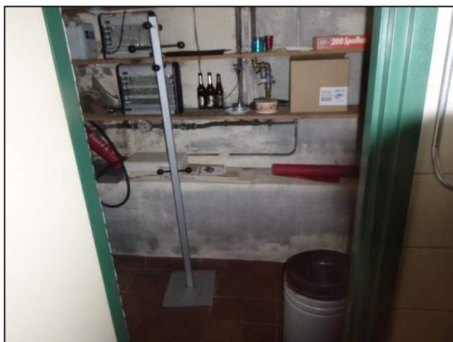
Foto 51: CV-ruimte: Wandafwerking (Niet asbestverdacht)
