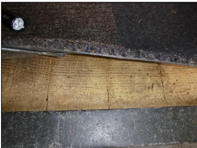
Foto 27: Hal: Onder vloerafwerking (Niet asbestverdacht)
