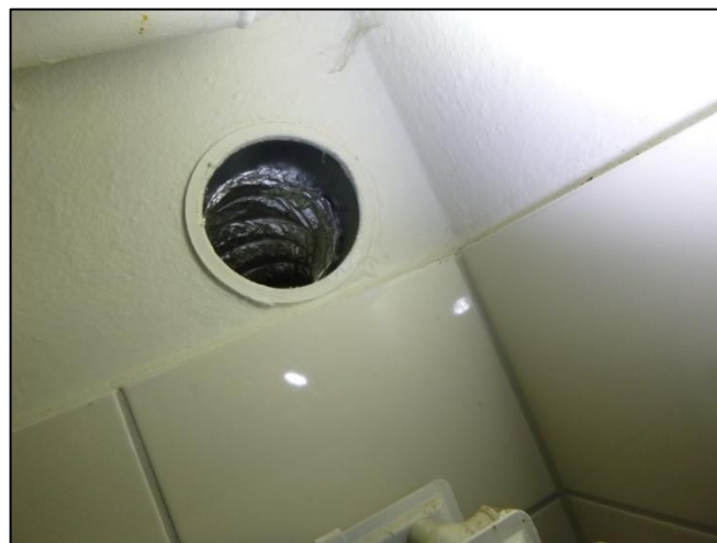
Foto 50: Keuken: Ventilatiekanaal (Niet asbestverdacht)
