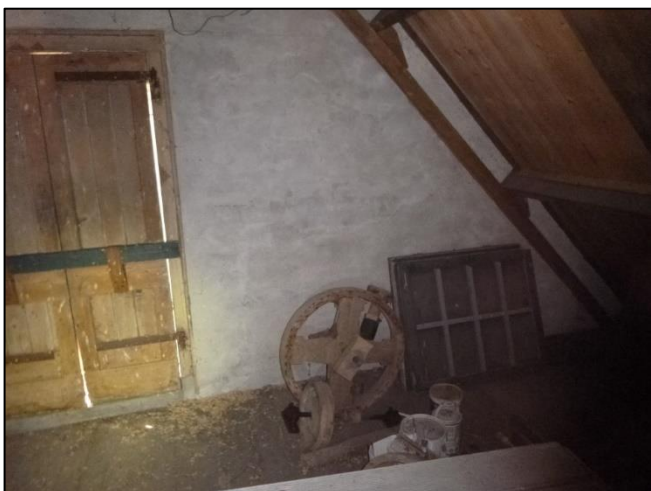
Foto 3: Zolder: Wandafwerking (Niet asbestverdacht)
