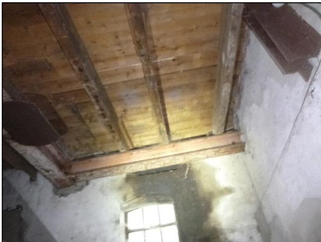
Foto 13: Kelder: Plafondafwerking (Niet asbestverdacht)
