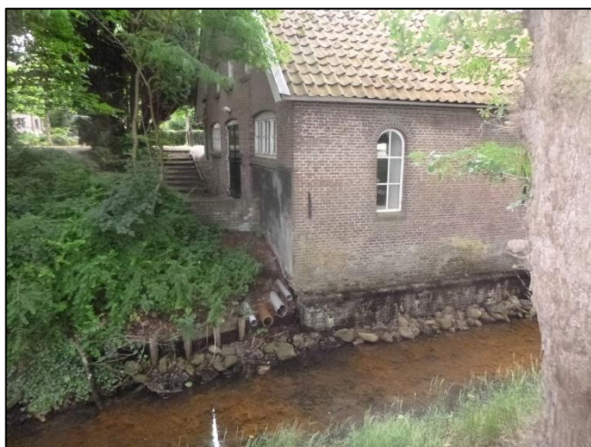
Foto 23: Buitengevel: Buizen (Niet asbestverdacht)
