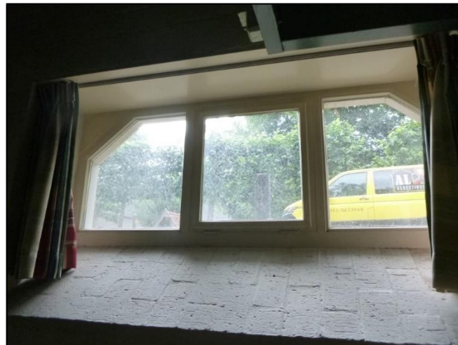
Foto 44: Zaal: Beglazingskit (Niet asbestverdacht)
