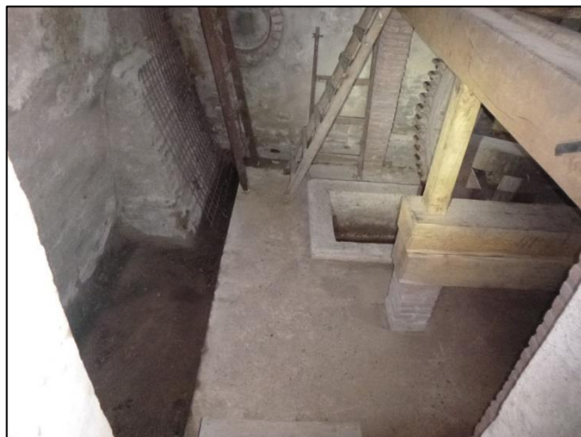
Foto 16: Kelder: Vloerafwerking (Niet asbestverdacht)
