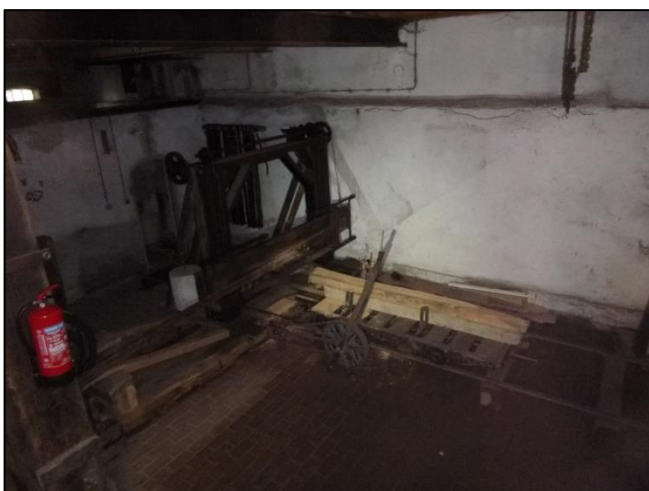
Foto 11: Kelder: Wandafwerking (Niet asbestverdacht)
