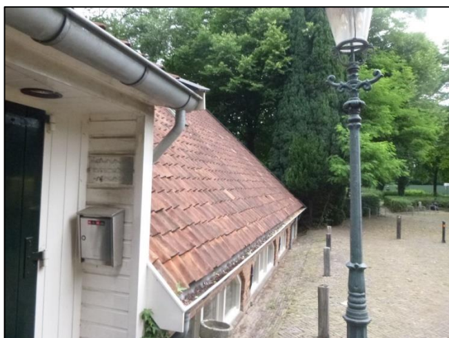
Foto 53: Buitengevel: Hemelwaterafvoer (Niet asbestverdacht)
