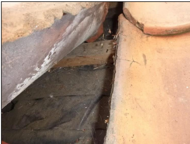
Foto 25: Korenschuur: Dakbeschot (Niet asbestverdacht)
