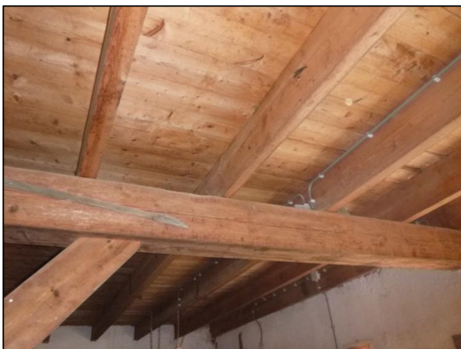
Foto 7: Begane grond: Plafondafwerking (Niet asbestverdacht)
