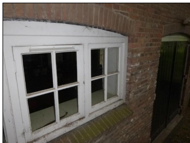
Foto 54: Buitengevel: Beglazingskit (Niet asbestverdacht)
