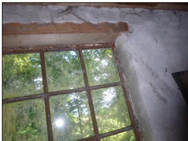
Foto 4: Zolder: Stopverf (Niet asbestverdacht)
