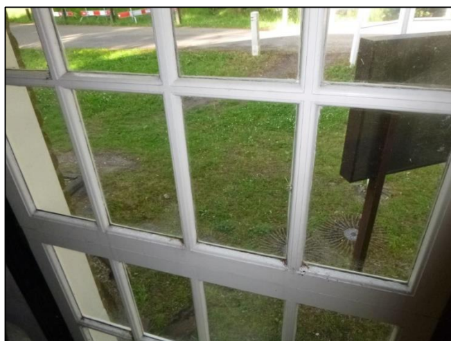
Foto 6: Begane grond: Beglazingskit (Niet asbestverdacht)
