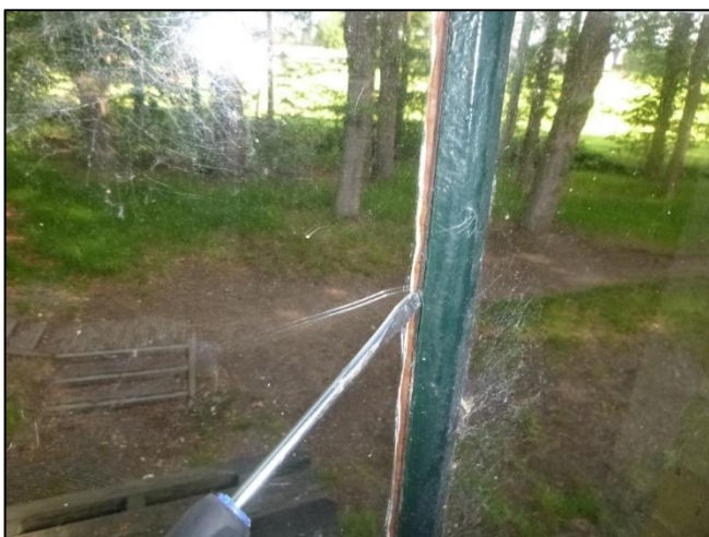
Foto 9: Begane grond: Beglazingskit (Niet asbestverdacht)
