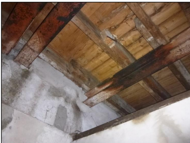
Foto 15: Kelder: Wandafwerking (Niet asbestverdacht)
