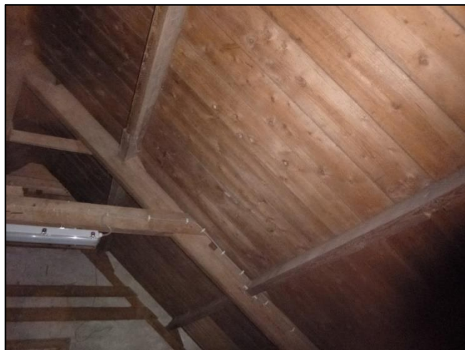
Foto 2: Woonhuis: Dakbeschot (Niet asbestverdacht)
