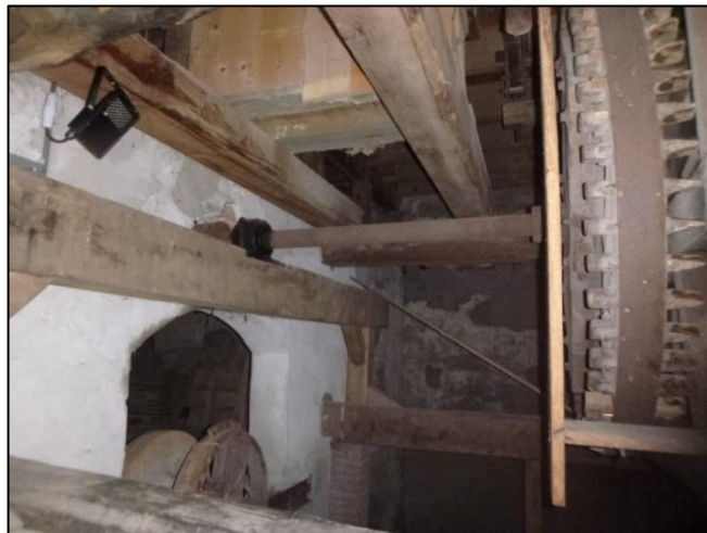
Foto 14: Kelder: Tandwielen (Niet asbestverdacht)
