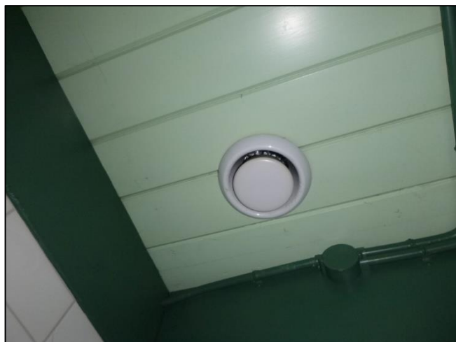
Foto 30: Toilet: Ventilatiekanaal (Niet asbestverdacht)
