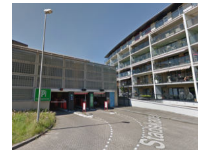
Parkeergarage Haven Centrum Capaciteit: 530 Gebruik: 10% Bezettingsgraad (za/do): 50%/50% Kosten per uur (doordeweeks): 1 euro Eigendom: Gemeente
