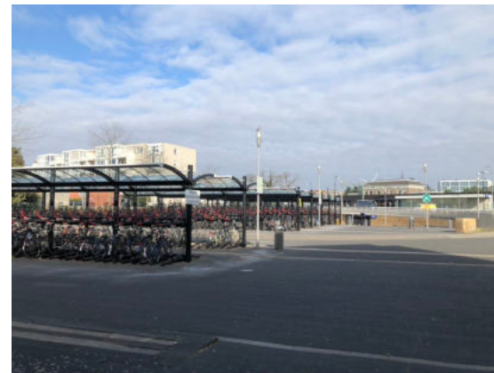
Achterkant station Functionele invulling: fietsenstalling en P&R
