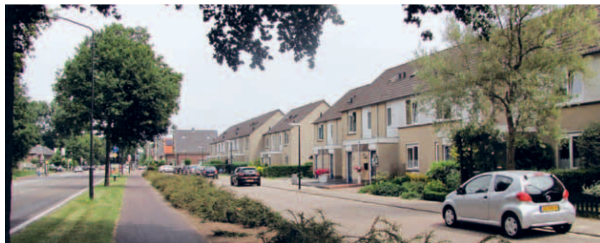
> Rand: de Deventerstraat. De gesloten gevelwanden van de lage bebouwing langs de parallelweg schermen de wijk af van de omgeving. Oudere bebouwing staat haaks op de weg, nieuwe parallel eraan.
