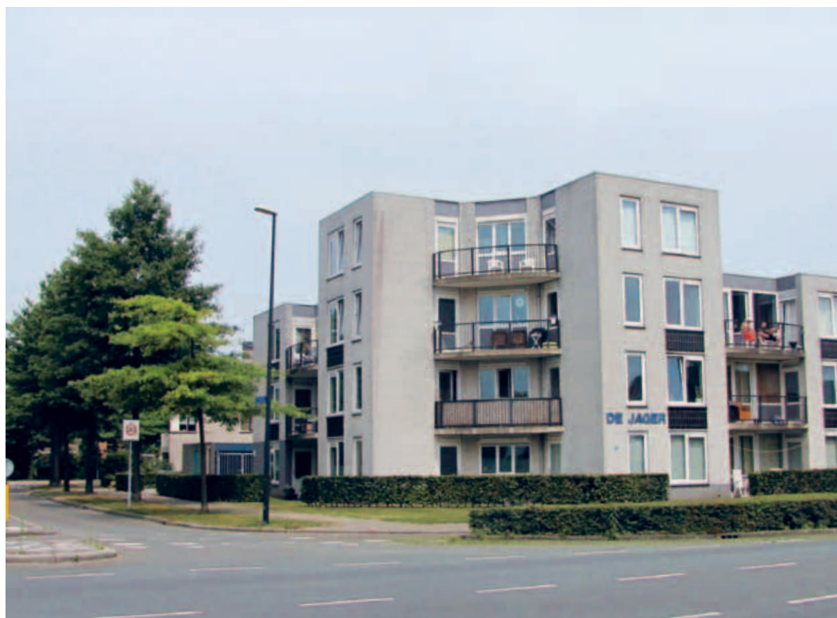
> Bescheiden hoogbouw in de vorm van een klein torentje van vier verdiepingen markeert de ingangen van de wijk.
