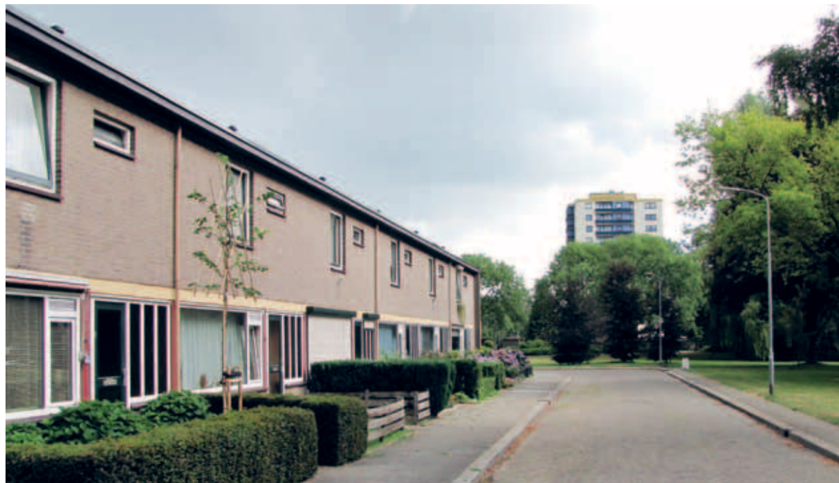
> De horizontale betonbalk is geel geverfd en iedereen deed mee. Door de zonwering en rolluiken wordt de doorgaande lijn helaas opgeknipt.
