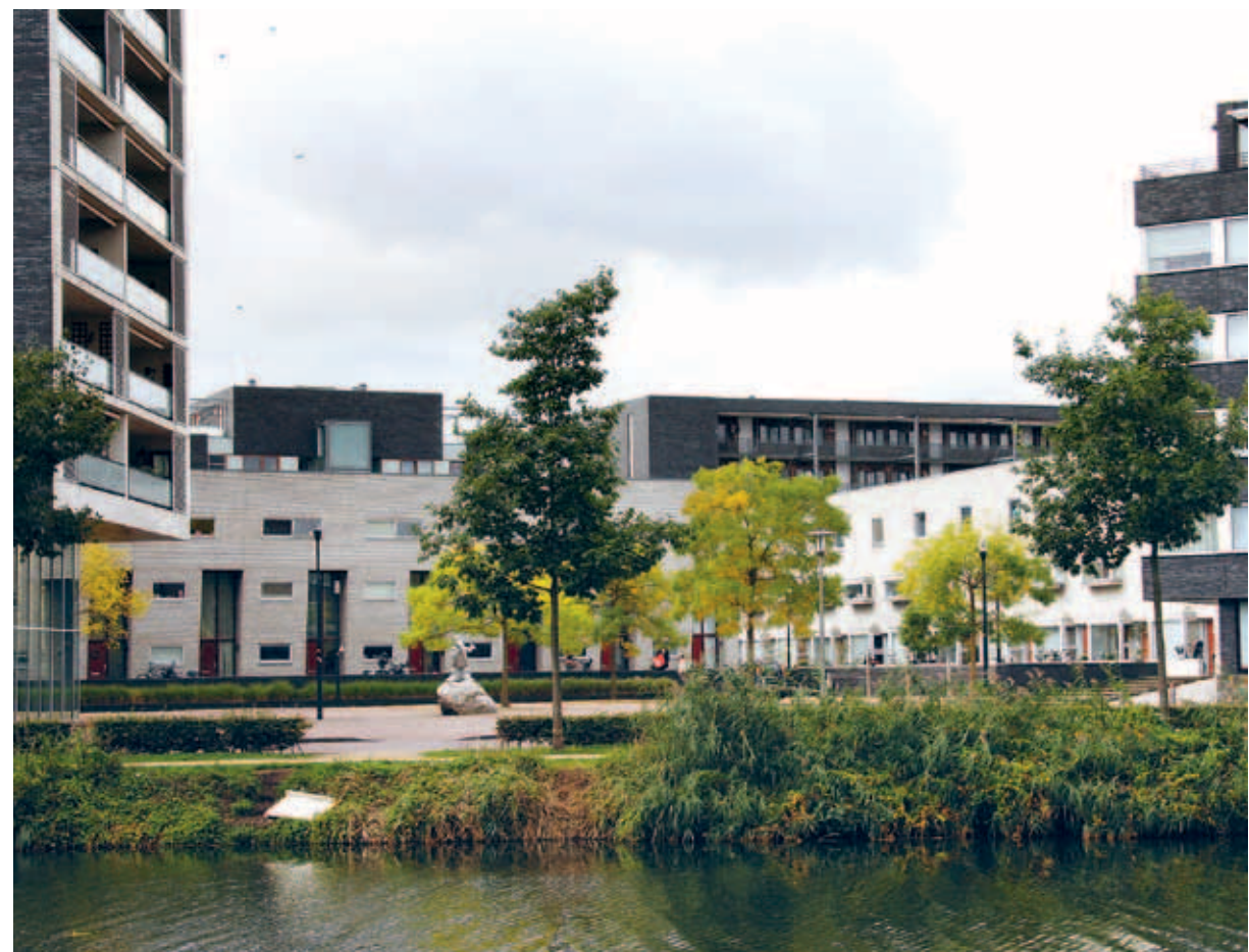
> Het contrast tussen de harde buitenschil en de zachtere binnenkant wordt extra benadrukt door de kleuren van de bebouwing en het type beplanting: donker en robuust aan de buitenzijde en licht en subtiel aan de binnenzijde.
