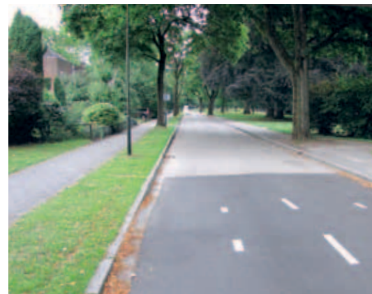
> Een onlogische plek voor een overgang van oud en nieuw asfalt midden in een straat. Het duurt jaren voordat het storende verschil in asfaltkleur vermindert.
