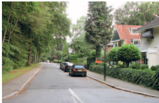
> Overgangen tussen oud en nieuw asfalt vallen bij voorkeur samen met logische plekken zoals hoeken van straten en bestaan uit asfalt van dezelfde samenstelling.
