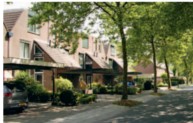
> Deze carports zijn (bijna) zwevende dakjes waar je gewoon onderdoor kunt kijken en zicht hebt op de voordeuren en de ramen. Ze dicht maken zou het straatbeeld verarmen.
