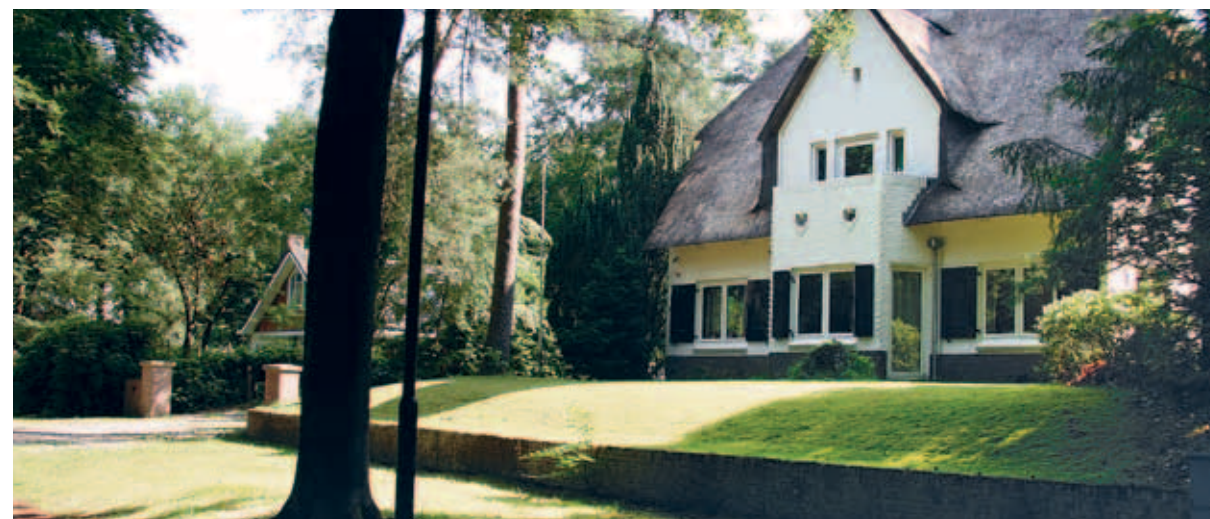
> Het hoogteverschil is aangegrepen om de grens tussen kavel en straat te verscherpen en het huis op een presenteerblaadje te zetten.
