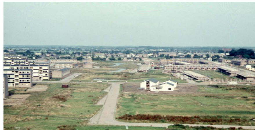
Kerschoten in aanbouw, vanaf De Veenkamp (foto Gemeentewerken Apeldoorn).
