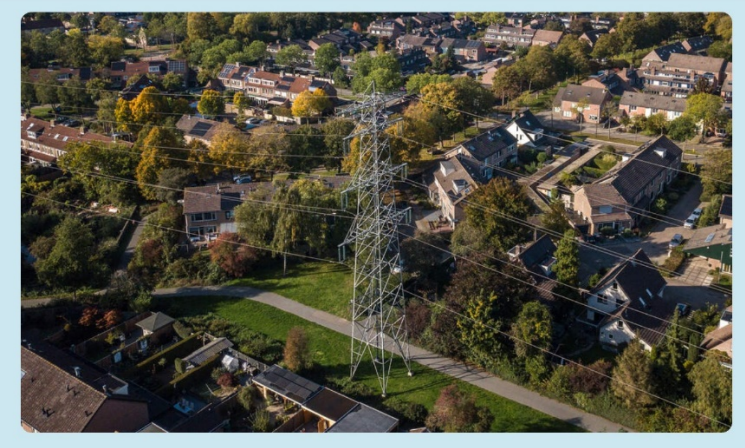
Mast 19, locatie ondertekening realisatieovereenkomst
