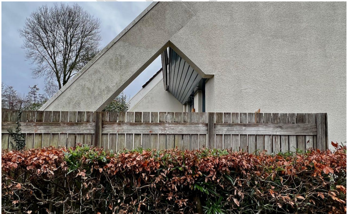
Tuinmuur met sparing
