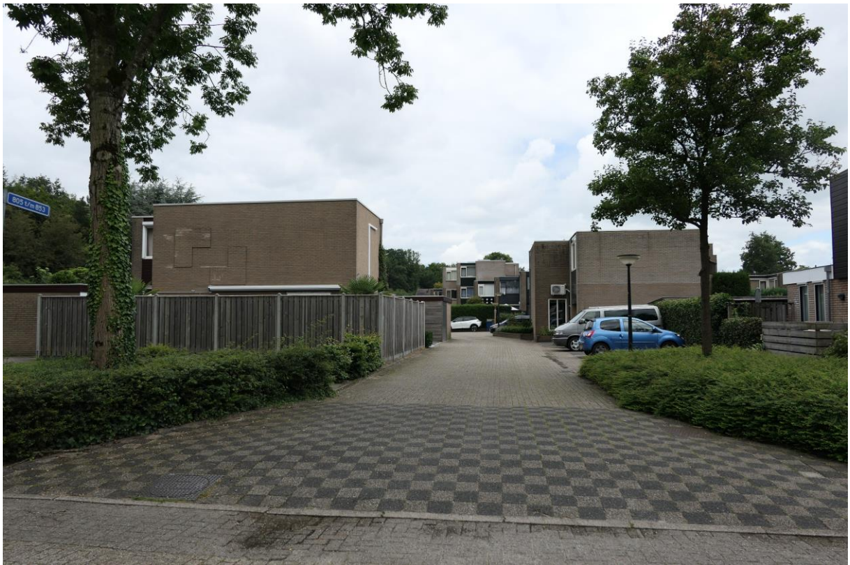
Siermetselwerk in de gevel
