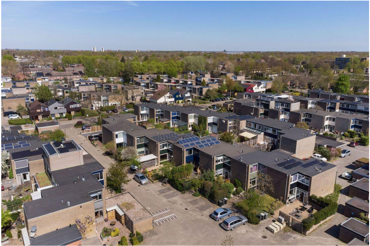
Overzicht van een van de woonerven aan de Rietdekkersdreef (foto via funda)
