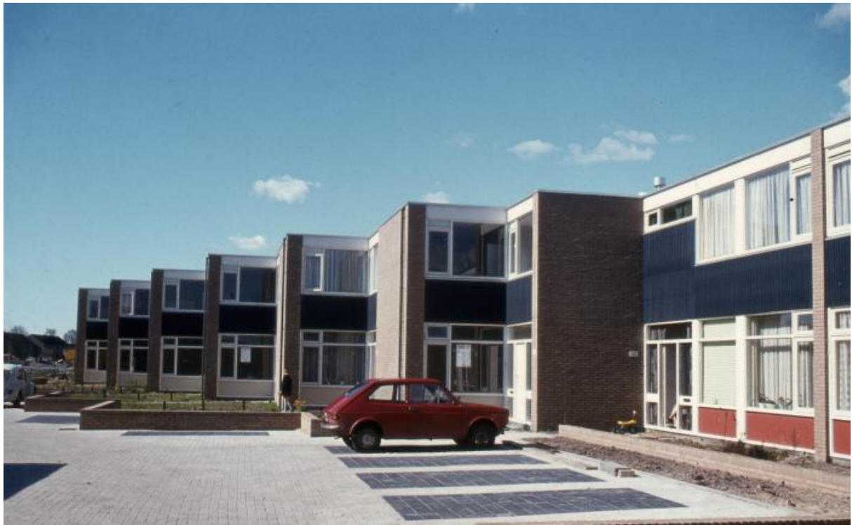
Woonblok van negen woningen met rechts de vlakke gevels in de knik, kort na oplevering in 1973
