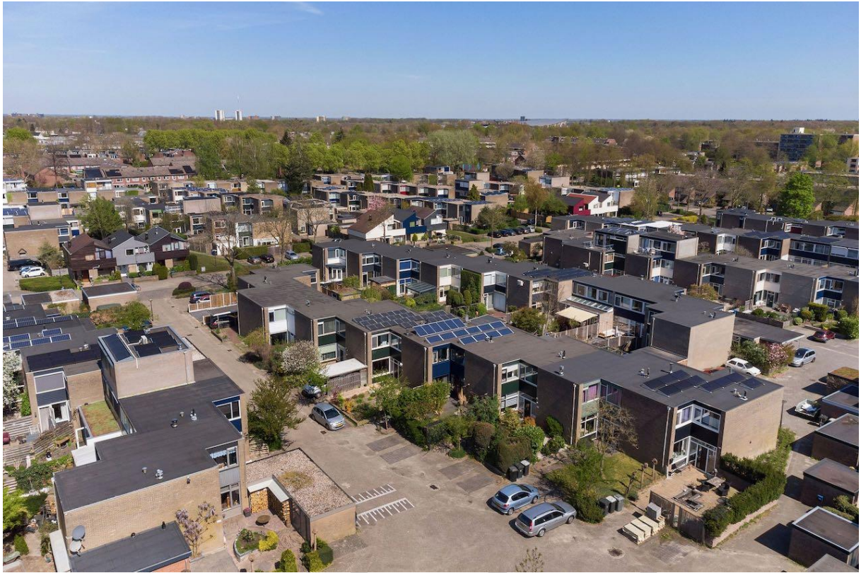
Overzicht van een van de woonerven aan de Rietdekkersdreef (foto via funda)
