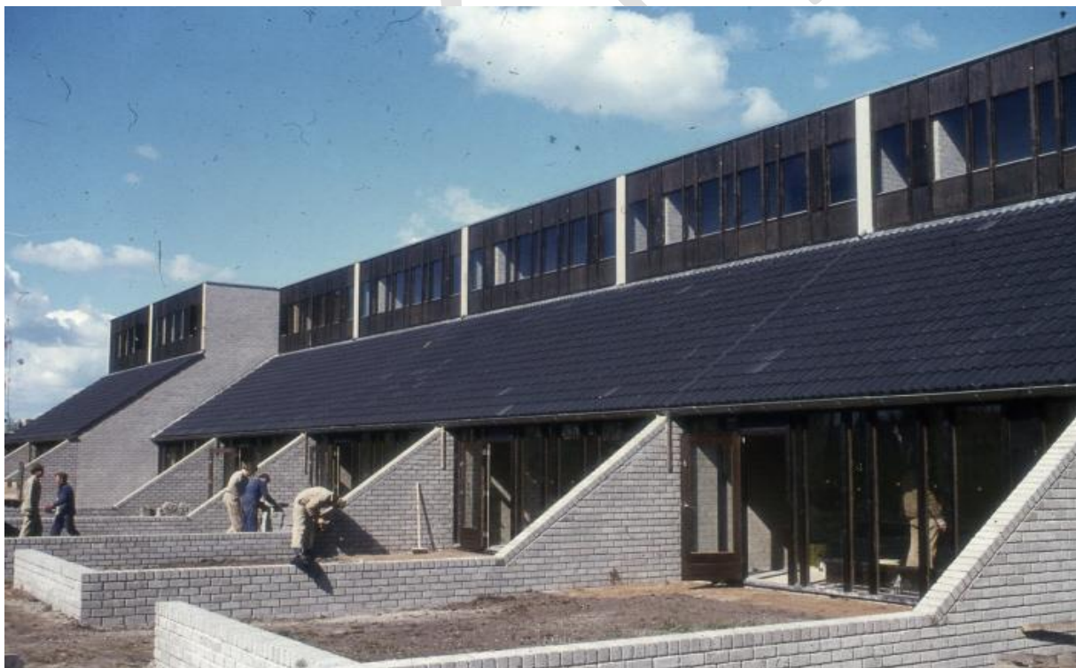
De woningen in de Maten kort na het gereedkomen van de bouw, 1973
