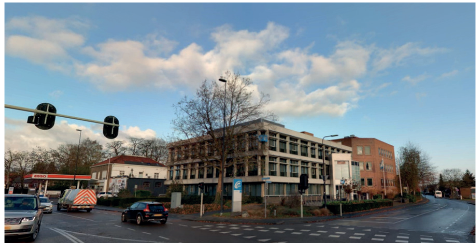
Kantoorgebouw UWV aan de Deventerstraat 43 - hoek Vlijtseweg / Kanaal
