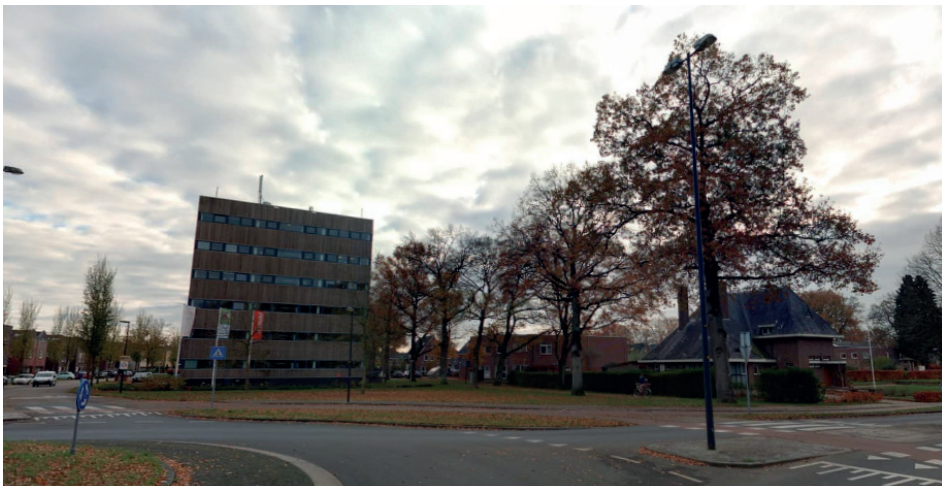
Kantoorgebouw op de hoek Deventerstraat - Tussen de Eiken 109
