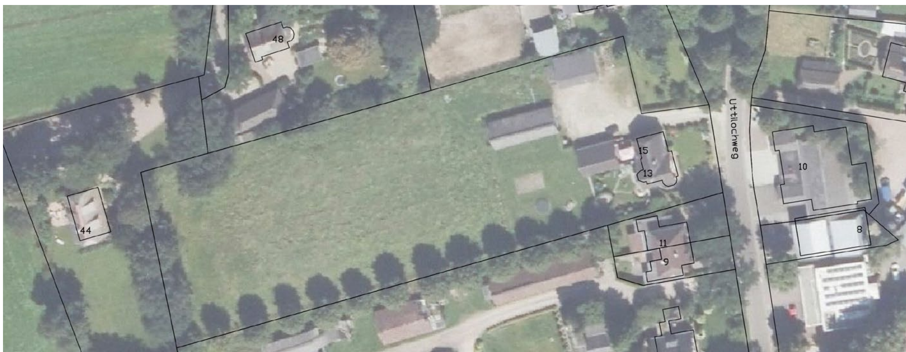
Kaartbeeld met huidig erf en te slopen opstallen
