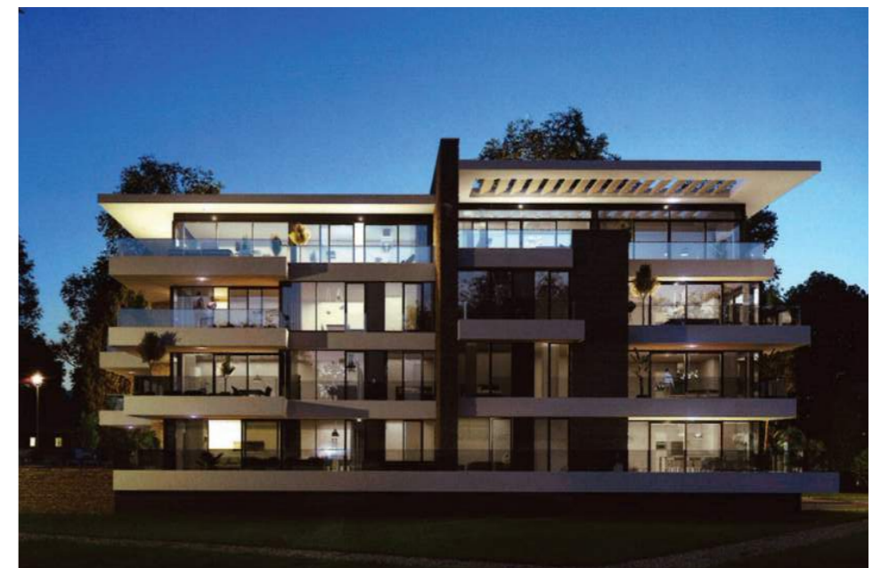
gebouwen hebben ruime dakoverstekken
