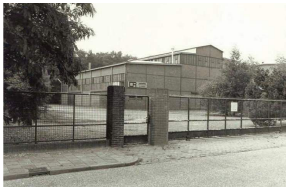
situatie 1983 grootschalige fabriekshallen van Remeha
