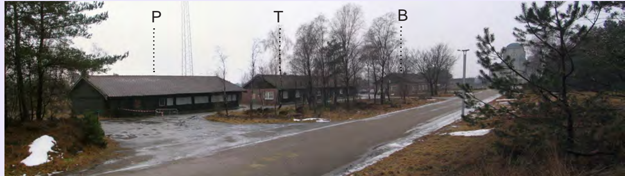
Situatie voorjaar 2010 inclusief loods B
