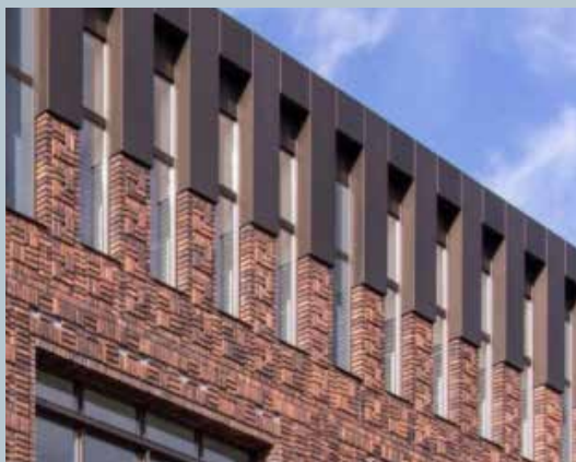
Gevelvlakken en textuur
