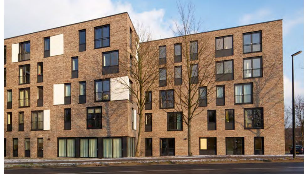
eenvoudige en functionele gevelopeningen
