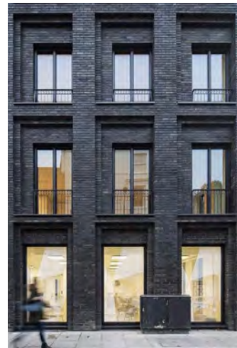
schaal in metselwerk
