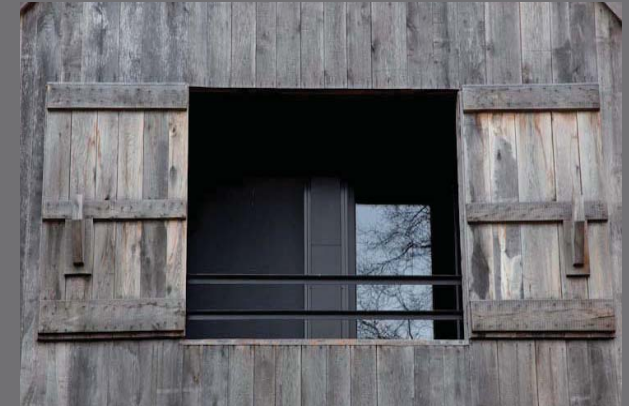
Nieuwe gevels achter oorspronkelijke houten gevels zorgen voor een ingenieus inpandig balkon.
