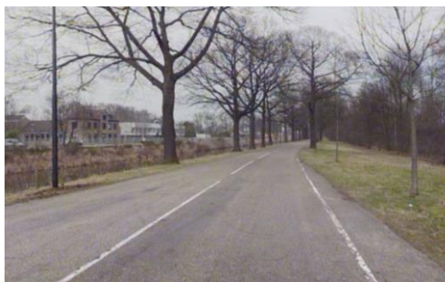
Figuur 3 Kanaal Zuid oostzijde (2003) ingericht als busbaan (niet meer in gebruik)
