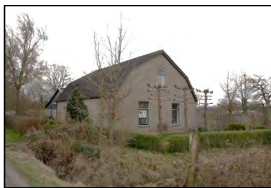
Figuur 3. Gevel noordzijde woonhuis Kieveen 10.
