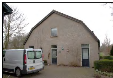
Figuur 4. Gevel zuidzijde woonhuis Kieveen 10.
