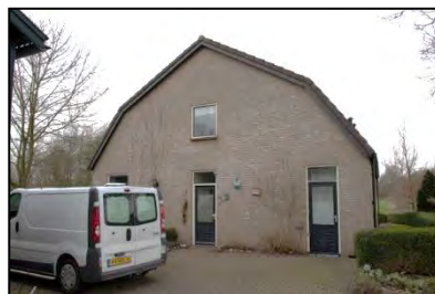
Figuur 4. Gevel zuidzijde woonhuis Kieveen 10.
