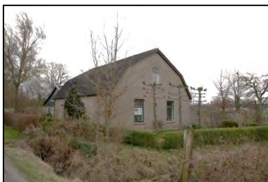
Figuur 3. Gevel noordzijde woonhuis Kieveen 10.
